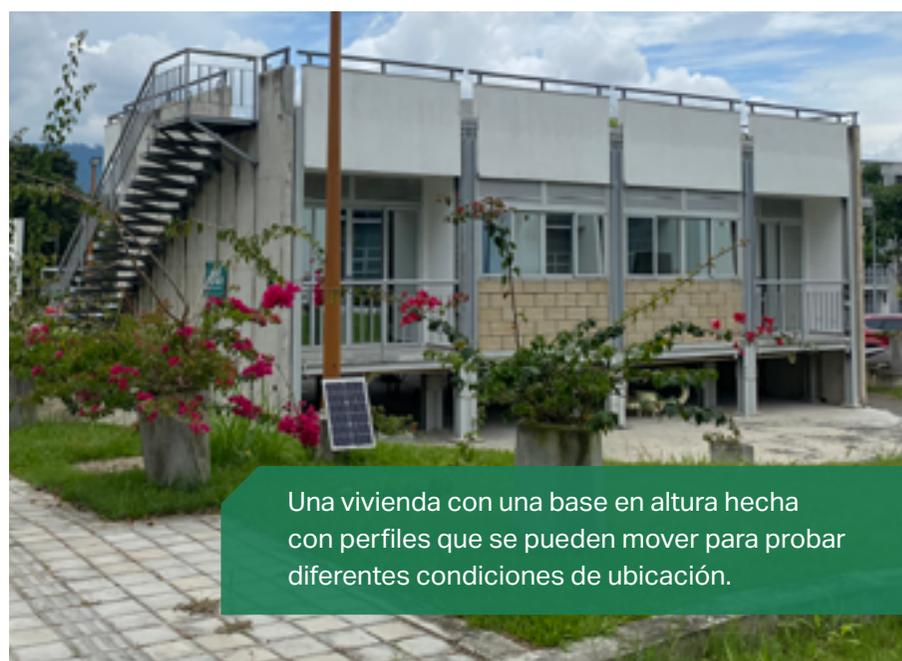
Una vivienda con una base en altura hecha con perfiles que se pueden mover para probar diferentes condiciones de ubicación.
